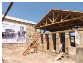
Строительные работы по восстановлению объекта
