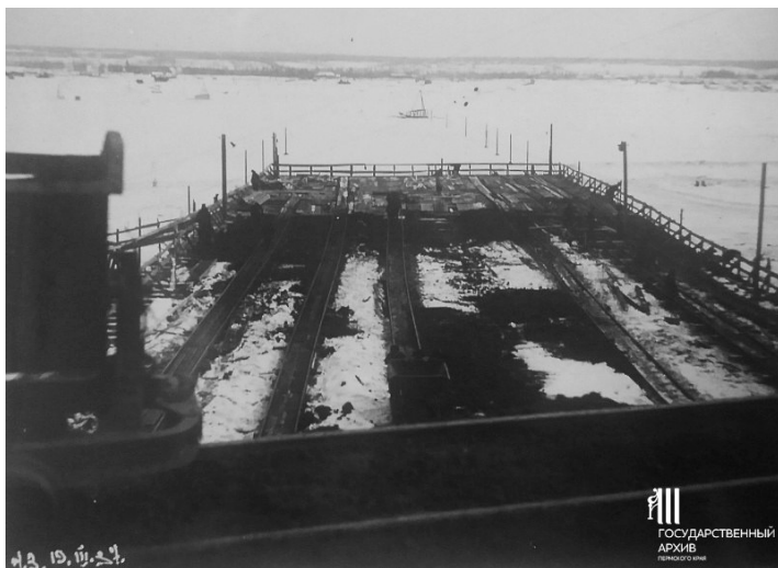
Рис. 1. Строительство Камской ГЭС, март 1937 года [1]
