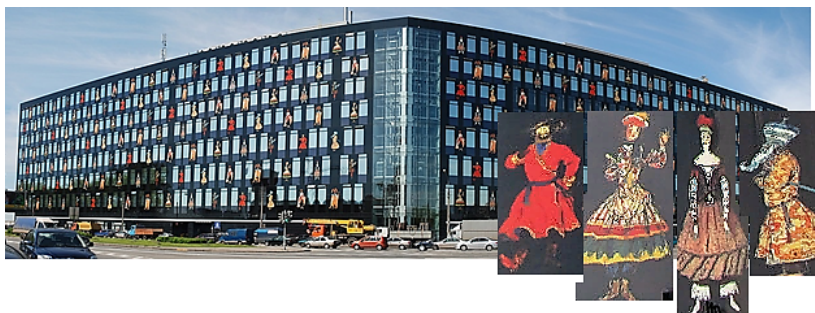
Рис. 48. Бизнес-центр «Бенуа» (2008 г.) – офисное здание с витражами по эскизам А. Н. Бенуа (1870–1960) для балета «Петрушка». Архитектор С. Э. Чобан (архитектурное бюро NPS Tchoban Voss, Германия) 120
