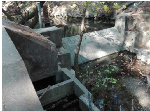
Рис. 1. Плотина на р. Лутанис
