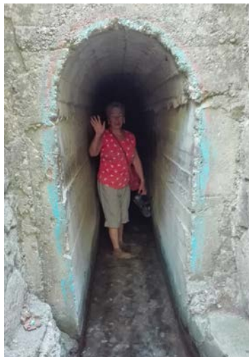
Рис. 2. Бетонный туннель для пропуска воды р. Лутанис
